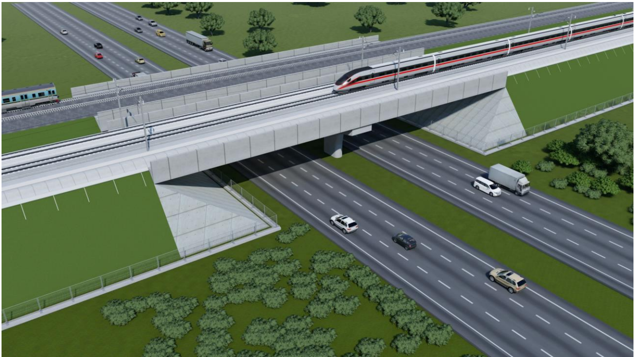
รูปที่ 15 สะพานรถไฟข้ามทางรถยนต์
