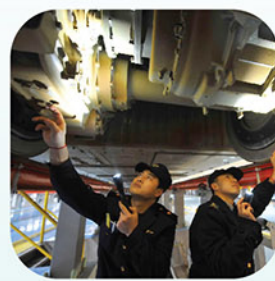
การบำรุงรักษาและซ่อมแซม
