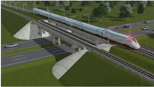
สะพานรถไฟ (Railway Bridge)
